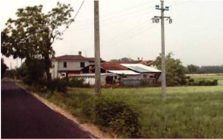
Foto n°6: Panoramica di Fornaci Crenosi
