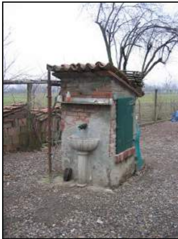
Foto n°3: Un tipico pozzo a camicia utilizzato per le misure freatiche ubicato in loc. Crocetta
