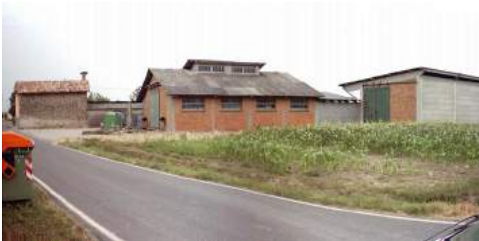
Foto n°7: Panoramica di C.na Belvedere
