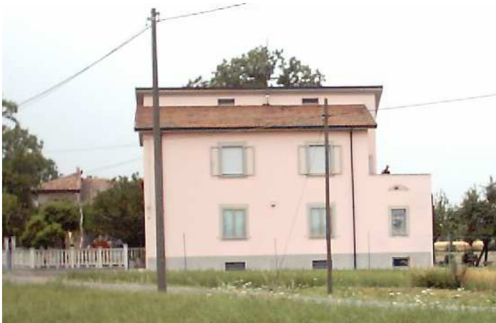
Foto n°16: Panoramica di un edificio isolato ubicato in zona Sordello
