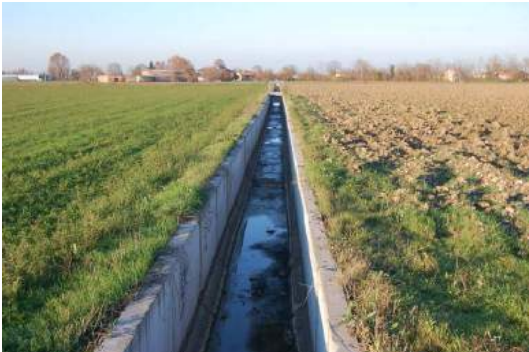
Foto n°32: Particolare del tratto di rio Gragnano, che delimita il comparto verso ovest, recentemente impermeabilizzato
