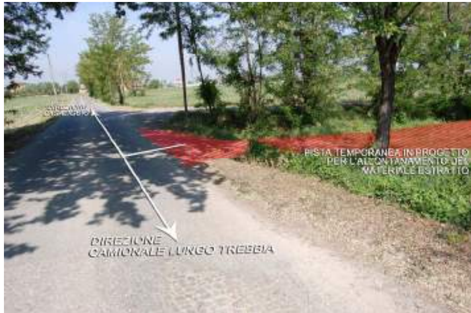
Foto n°3: Particolare dell'accesso agricolo esistente di cui è previsto l'adeguamento nell'ambito
