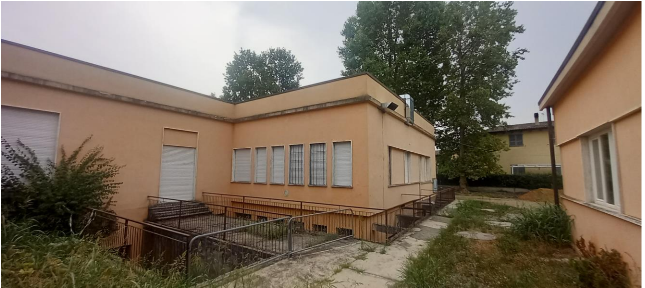
Vista cortile interno
