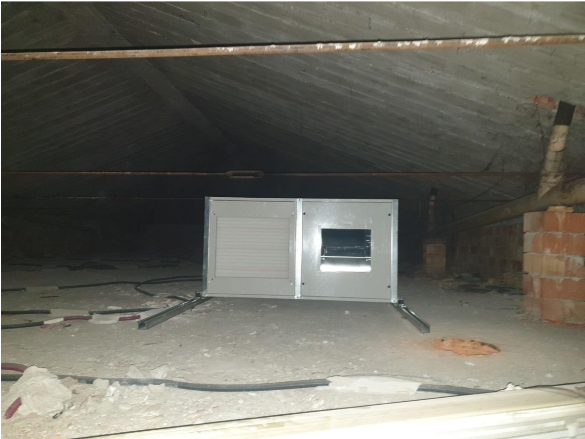
Vista sottotetto corpo C
