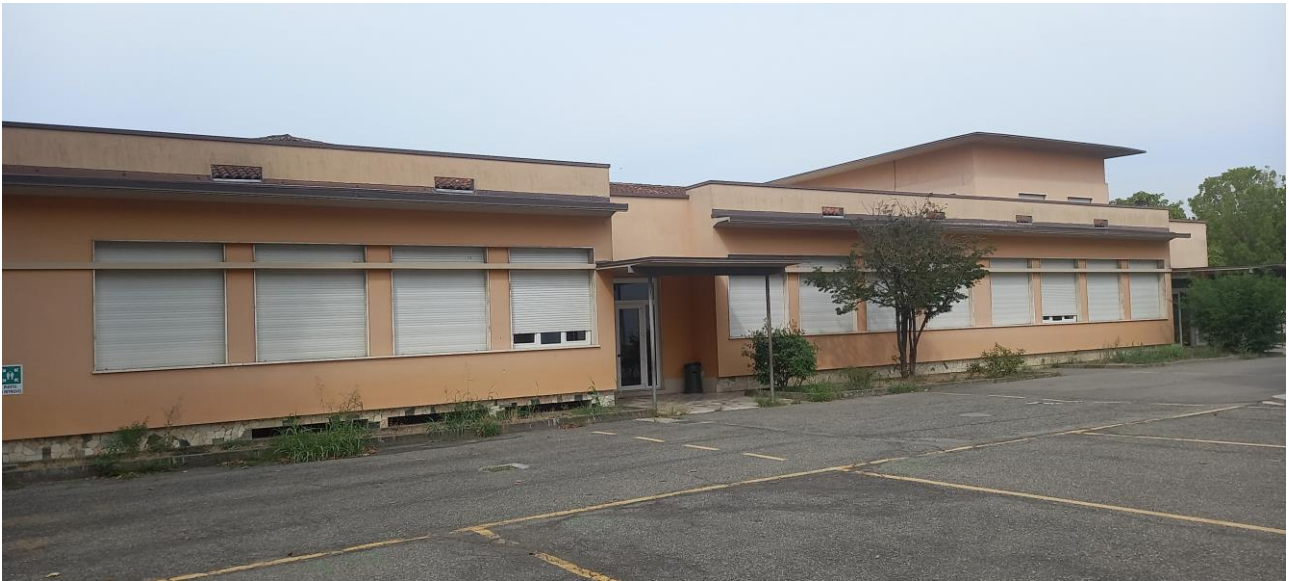
Vista fronte est corpo A- ingresso
