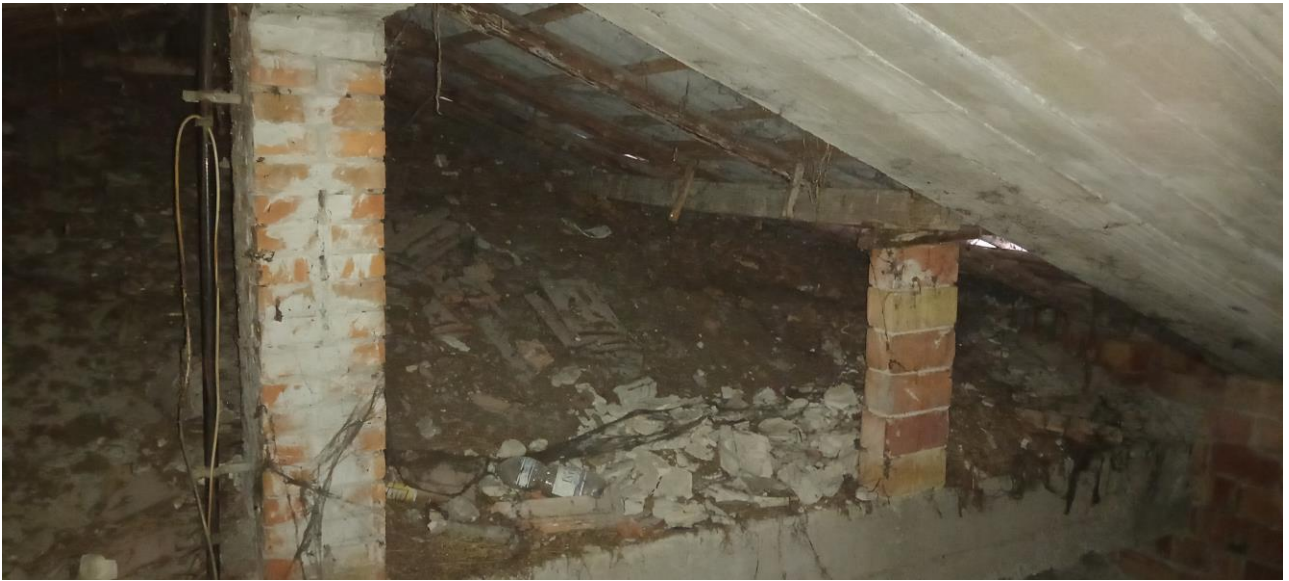
Vista sottotetto raccordo corpo A – corpo B
