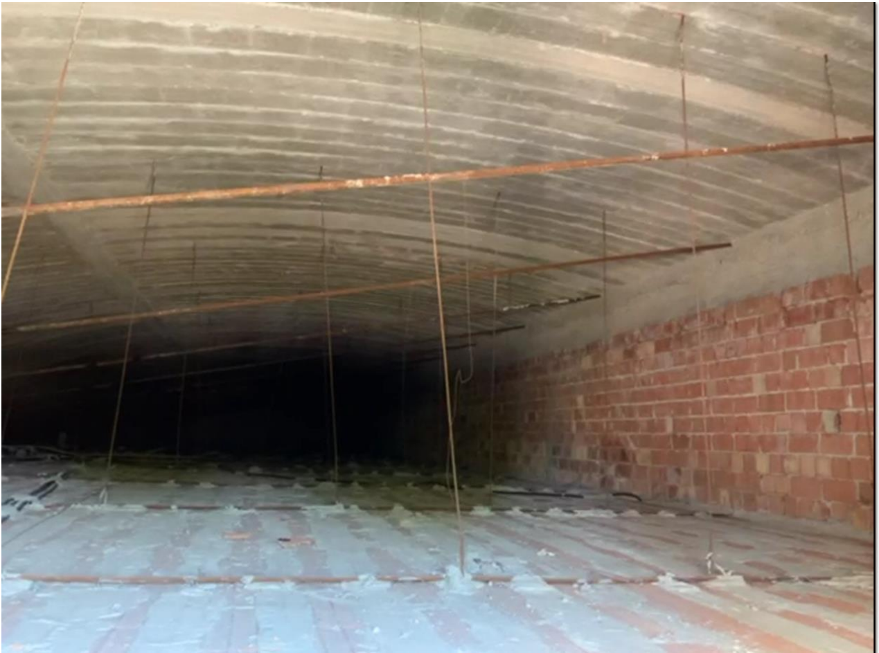
Vista sottotetto corpo D
