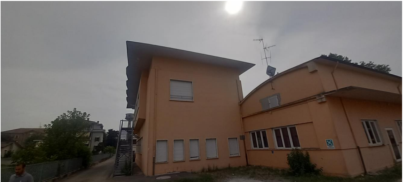
Vista fronte ovest corpo C
