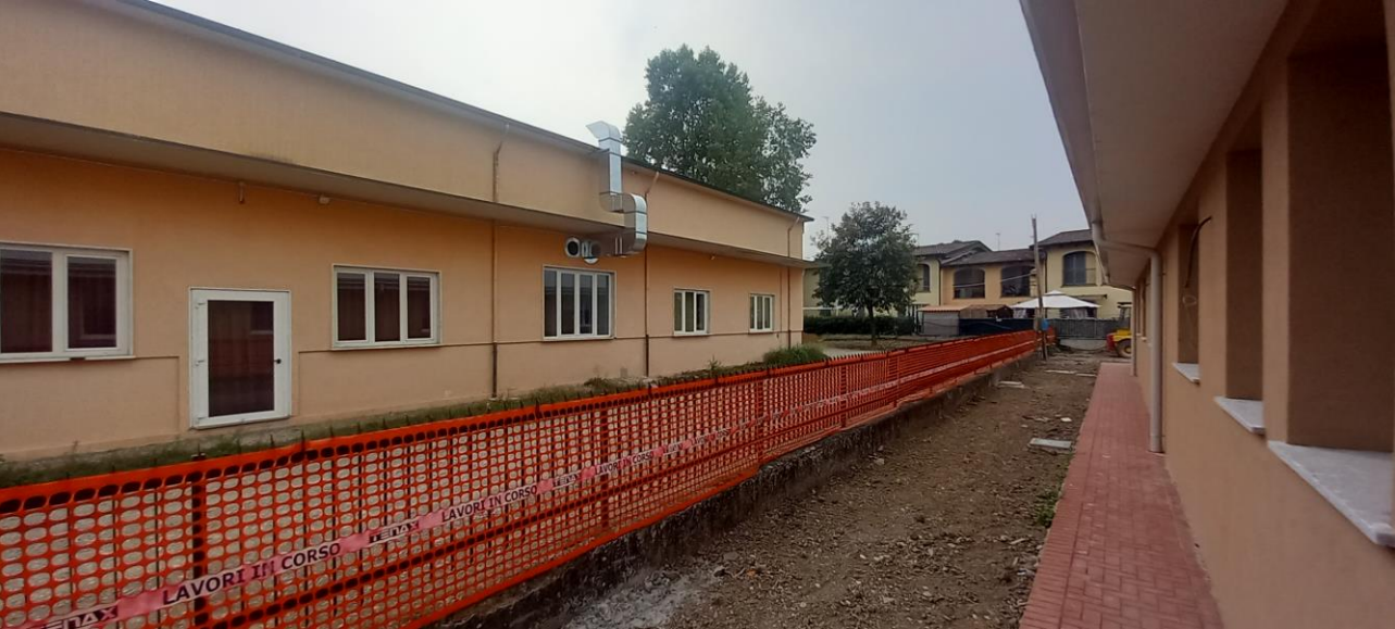
Vista fronte ovest corpo D
