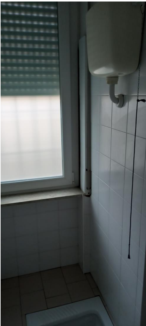
Vista interno bagni corpo B
