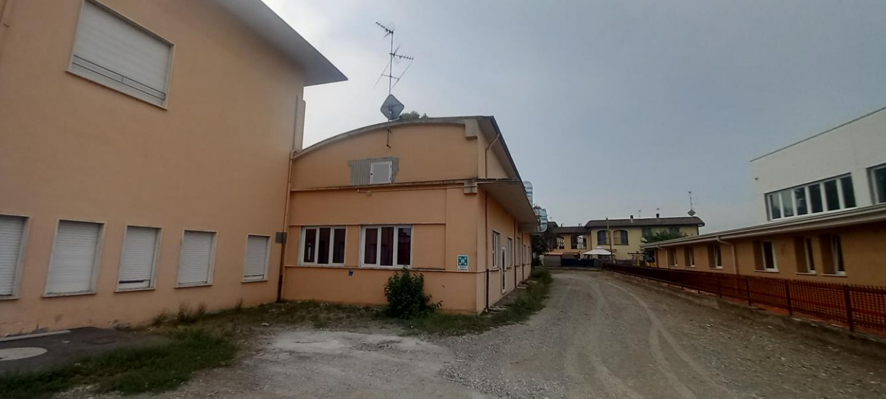
Vista fronte Nord Corpo D
