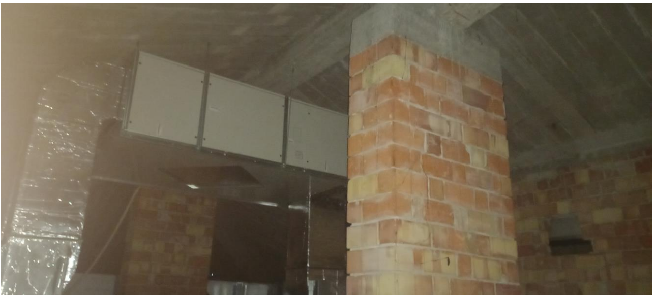
Vista sottotetto Corpo B
