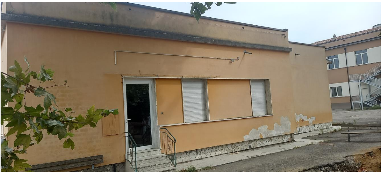
Vista fronte sud corpo B
