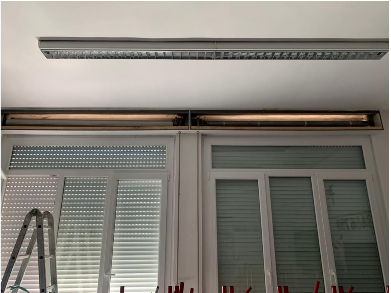
Vista interno corpo A
