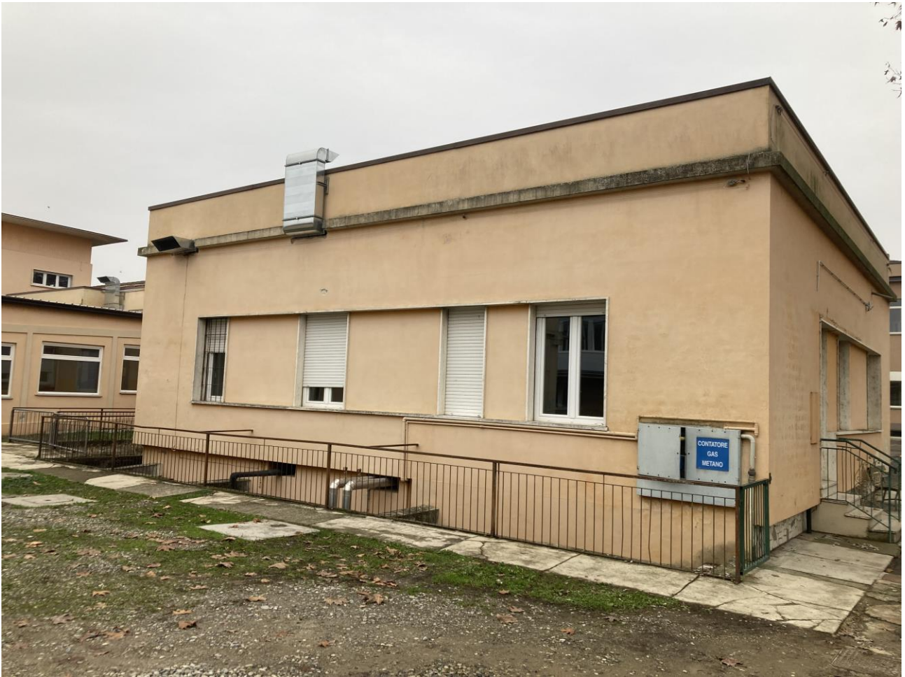
Vista fronte ovest corpo B
