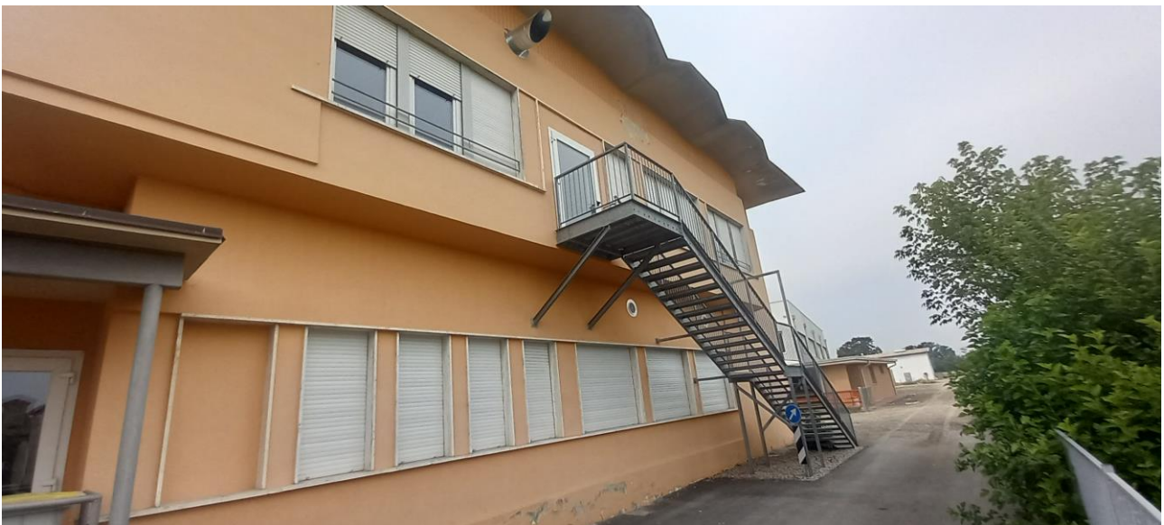
Vista fronte Nord corpo C
