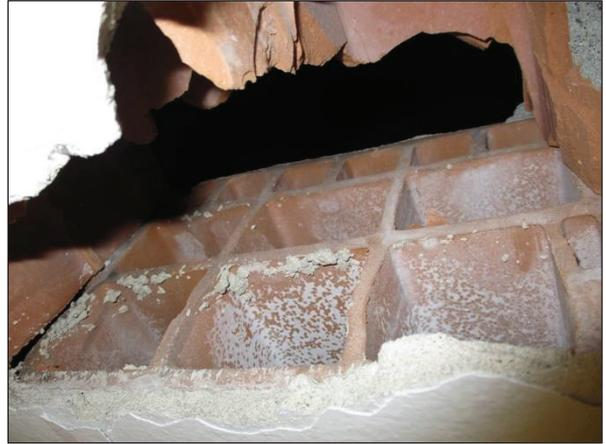
Foto n°26 - Particolare in cui è osservabile la geometria del laterizio che realizza il sistema di alleggerimento.
