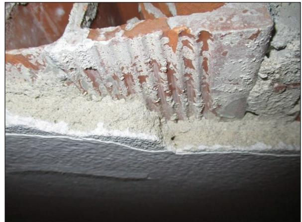
Foto n°24 - Dettaglio dello spessore dello strato di finitura del plafone.
