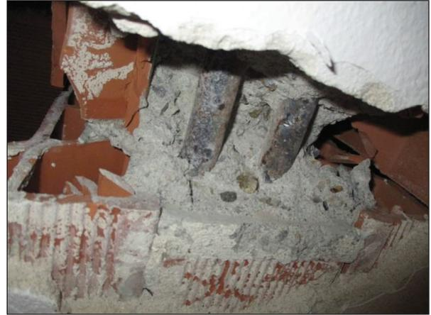
Foto n°22 - Particolare del travetto gettato direttamente in opera.
