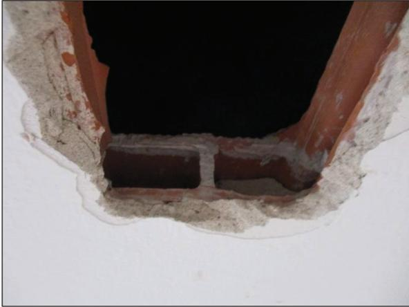
Foto n°33 - Individuazione della Tipologia Solaio D; demolizione puntuale eseguita nel locale Mensa 2 al piano terra.
