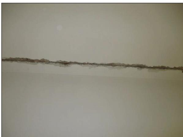
Foto n°41 - Porzione del plafone dell'Aula 2 al piano terra connotata da un grado di aderenza pessimo dello strato di finitura. Questa zona è connotata anche da una lesione che interessa il solo strato di finitura.
