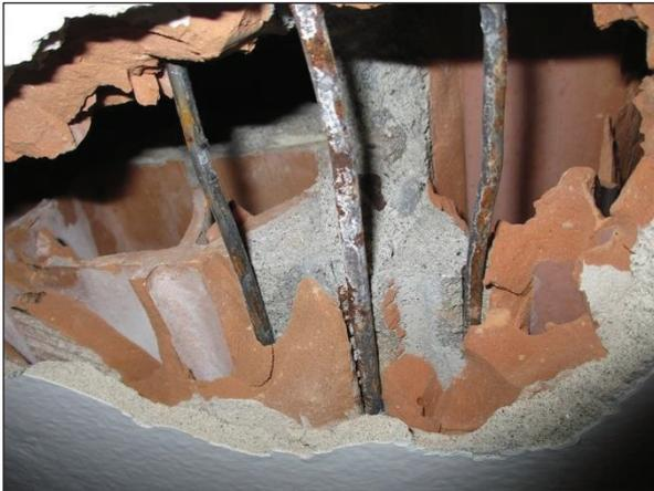
Foto n°31 - Particolare del travetto gettato direttamente in opera.
