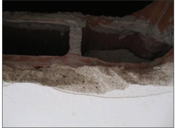
Foto n°34 - Dettaglio dello spessore dello strato di finitura del plafone.
