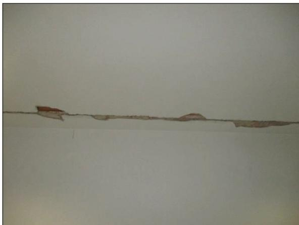
Foto n°40 - Porzione del plafone dell'Aula 3 al piano terra connotata da un grado di aderenza pessimo dello strato di finitura. Questa zona è connotata anche da una lesione che interessa il solo strato di finitura.
