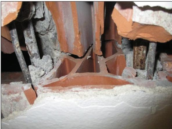
Foto n°27 - Particolare del travetto gettato direttamente in opera.
