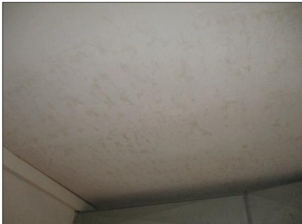
Foto n°37 - Efflorescenza superficiale che interessa il plafone del Corridoio 2 al piano terra.
