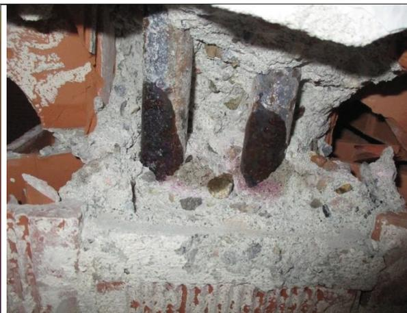
Demolizione puntuale dell'intradosso del solaio, disposta al fine di consentire il rilievo della conformazione costruttiva
