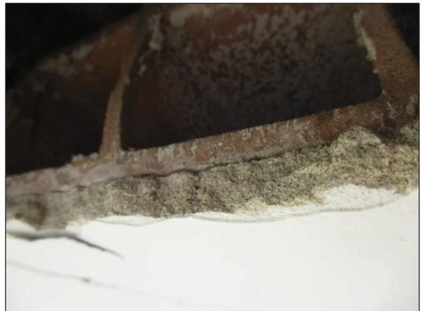
Foto n°28 - Dettaglio dello spessore dello strato di finitura del plafone.
