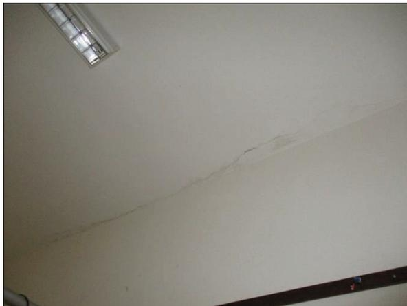
Foto n°38 - Porzione del plafone dell'Aula 4 al piano terra connotata da un grado di aderenza pessimo dello strato di finitura.
