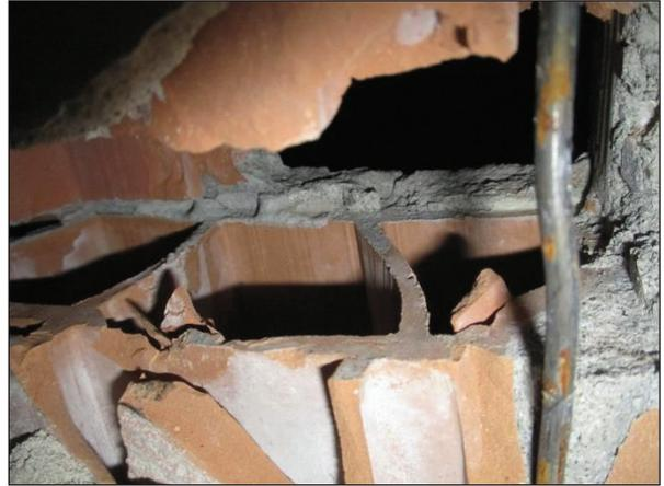
Foto n°30 - articolare in cui è osservabile la geometria del laterizio che realizza il sistema di alleggerimento.
