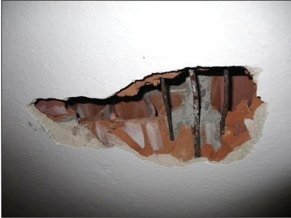
Foto n°29 - Individuazione della Tipologia Solaio C; demolizione puntuale eseguita nel Disimpegno 1 al piano terra.
