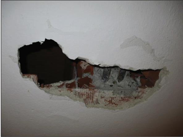
Foto n°21 - Individuazione della Tipologia Solaio A; demolizione puntuale eseguita nell'Aula 6 al piano terra.
