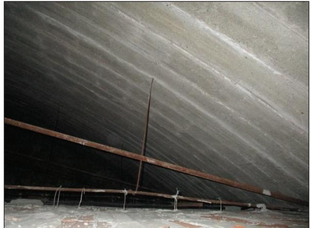
Foto n°36 - Individuazione del sistema di pendinaggio che mantiene in sospensione l'intradosso in tavelle.
