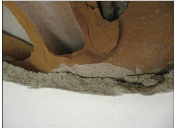
Foto n°32 - Dettaglio dello spessore dello strato di finitura del plafone.
