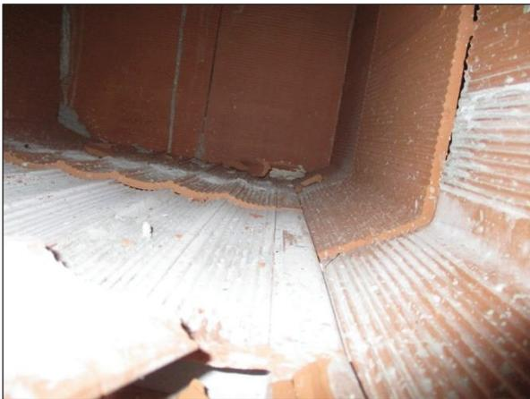
Foto n°23 - Vista interna dell'intercapedine formata dalla sovrapposizione del sistema di alleggerimento.
