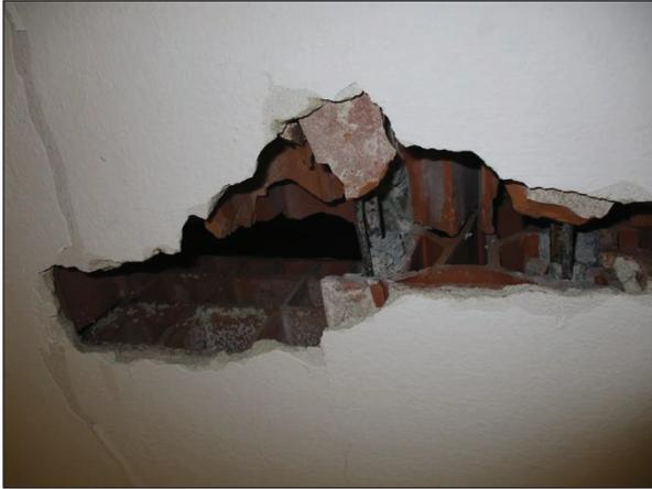
Foto n°25 - Individuazione della Tipologia Solaio B; demolizione puntuale eseguita nell'Aula 2 al piano terra.
