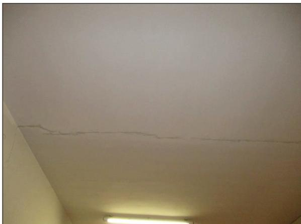
Foto n°39 - Porzione del plafone del Disimpegno 1 al piano terra connotata da una lesione che interessa il solo strato di finitura.
