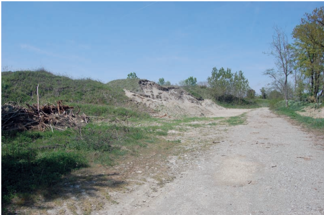
Foto n°8: Panoramica dell'area attualmente adibita a stoccaggio materiali inerti
