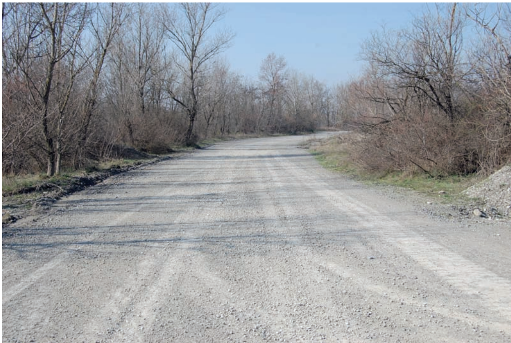
Foto n°3: La pista camionale lungo Trebbia
